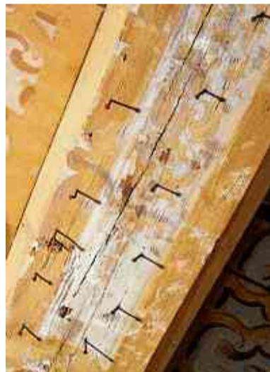
Diese Nägel sind Hinterlassenschaften einer früheren Zwischendecke. Tino Simon wird sie entfernen. FOTO: D. MAYER
