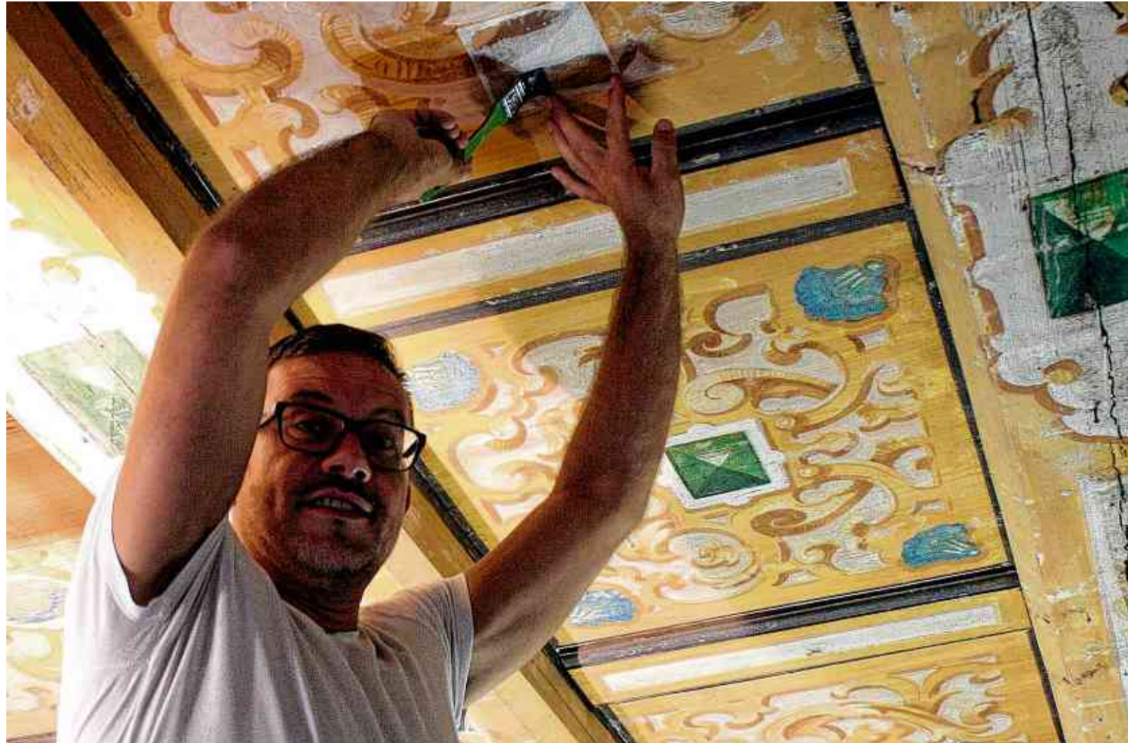
Das ständige Über-Kopf-Arbeiten unmittelbar unter der Kassetten-Decke ist bei der jetzigen Hitze kein Vergnügen für Restaurator Tino Simon.
